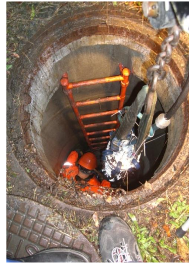
Abb. 2 Einbringung durch einen Dom
