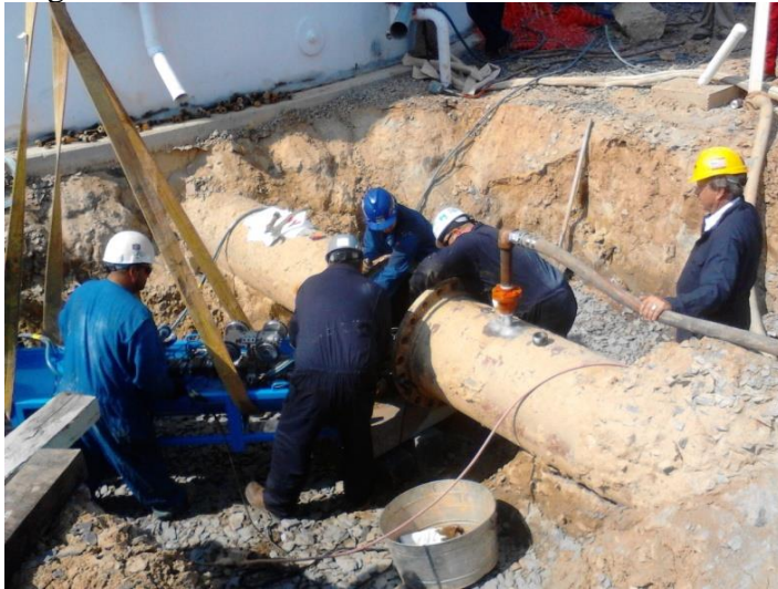
Abb. 1 Einbringen des Prüfsystems nach dem Ausbau eines Rohrsegments
