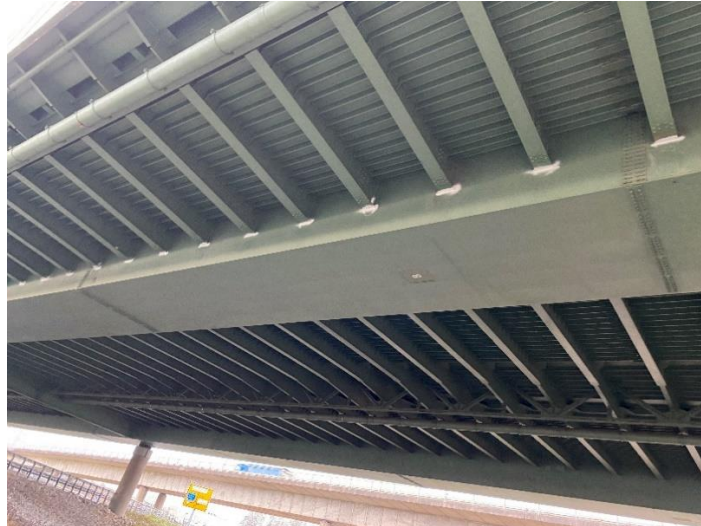
Abb. 1: Hohlkasten mit Kragarmen und Kehlnaht am T-Stoß.
