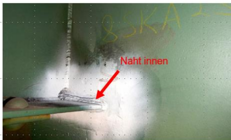
Abb. 3: Prüfstelle im Hohlkasten
